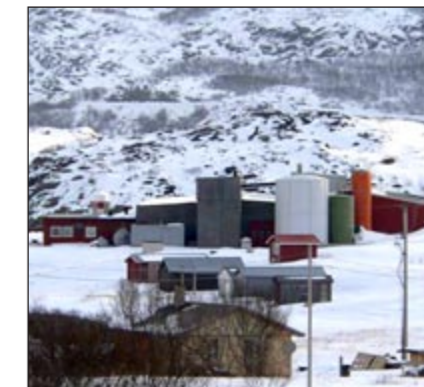
Grieg seafood har søkt om utvidelse av smoltanlegget i Adamselv. Foto: Jostein Pettersen
