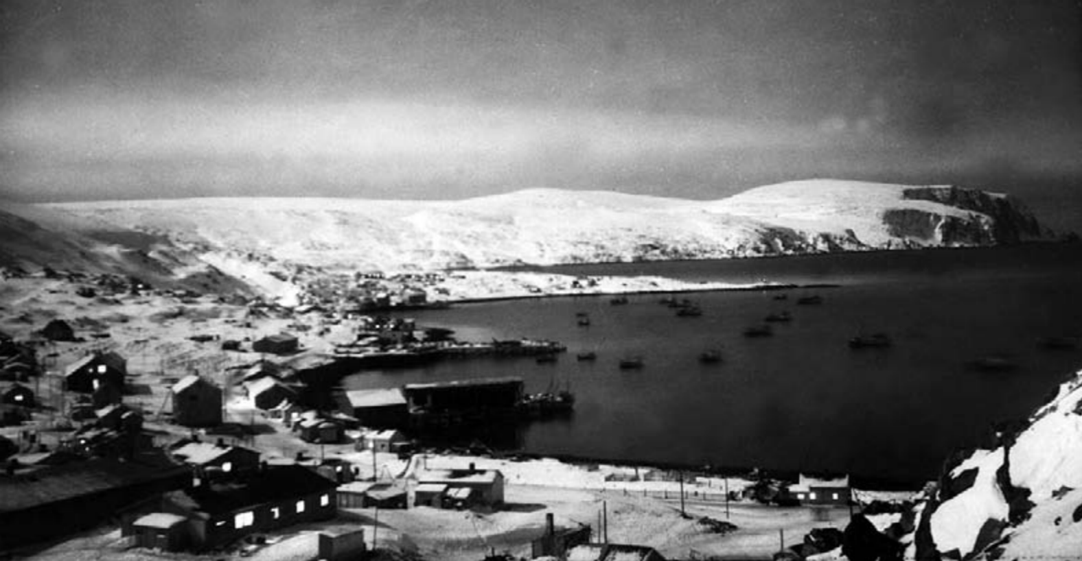
Vinter i Kjøllefjord. Det er etterkrigstid. Bildet er tatt i slutten av 1940 - eller begynnelsen av 1950-årene. Det er ennå ikke bygget molo i Kjøllefjord. Gjenreisningen er i gang. Til venstre i forgrunnen skolebrakkka hvor Helge Salmela gikk det første året på skolen. Ved siden av ser en danskebrakkka. Den var gitt som hjelp fra Danmark, derav navnet. Der bodde familien Vadel og Nøstberg. Ved sjøen til høyre ved Fiksekaia, ser en Anders Olsens brakke der barna kastet ball over taket. Foto: Nerlien, Oslo
