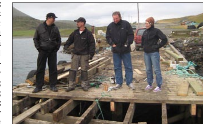
Den gamle fergekaia i Kalak er nå utbedret for 1,3 millioner kroner.
