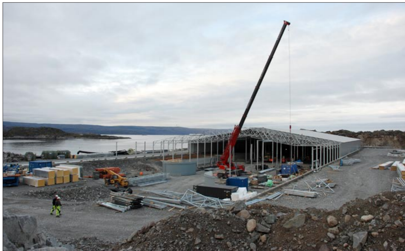
Det nye påvekstanlegget på 5000 kvadratmeter begynner å ta form i Landsersfjord.
