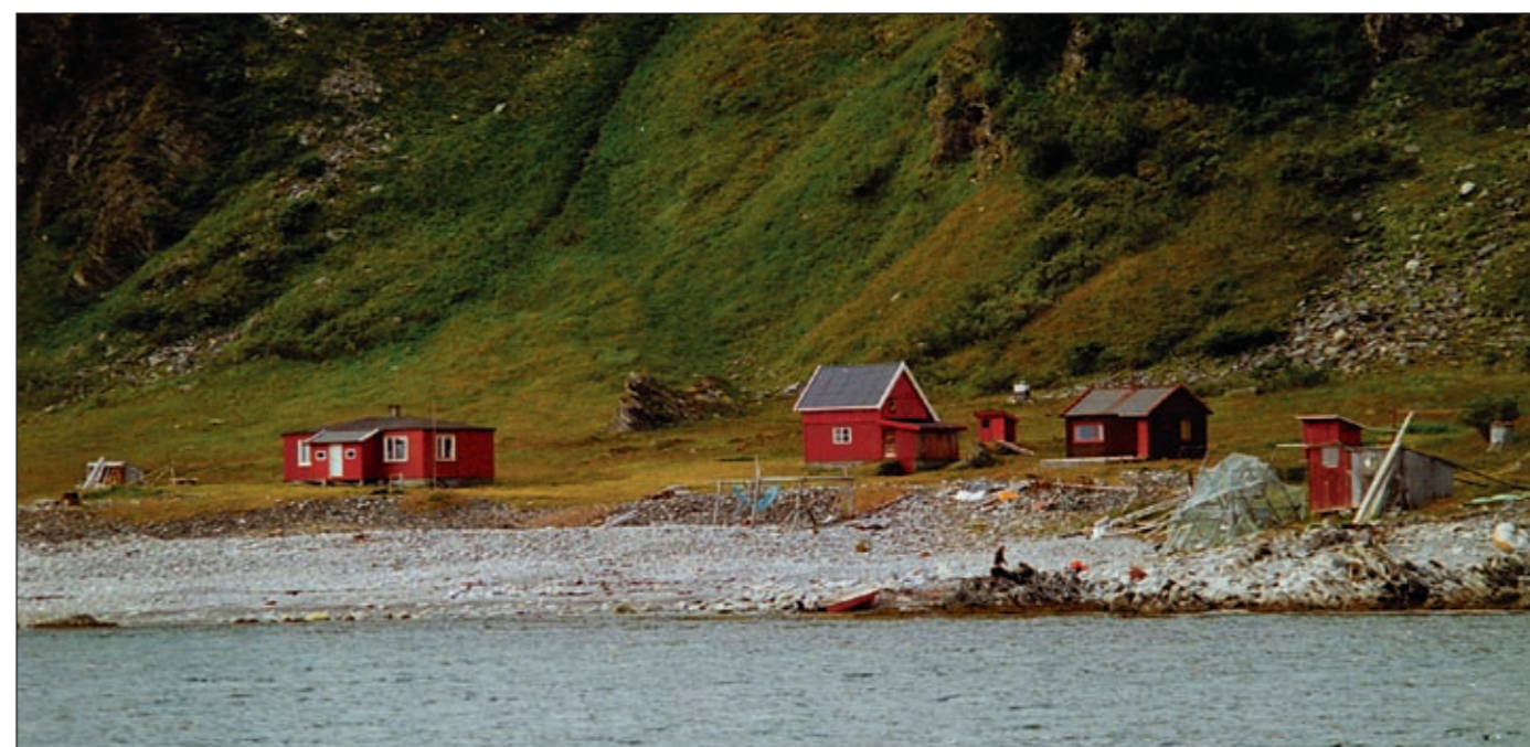
Liv Lauritsens barndomshjem i Barluft i Godvika. Husene er renoveret og pusset opp. Huset til venstre, med to soverom, huset til sammen ni personer. Fjøset, på midten er omgjort til beboelseshus. Hytta er nybygd og tilhører Knut Lauritsen. Utedoen er ny. Barluft 1992.
