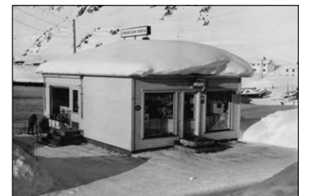
Den første lille kiosken til Amundsen ble etablert i 1952. Den ble solgt til bolighus etter åtte år, da dette nybygget kom opp i 1960. Amundsen kiosk står det på skiltet, på taket. Her i vinterskrud. Kjøllefjord 1960-tallet.
