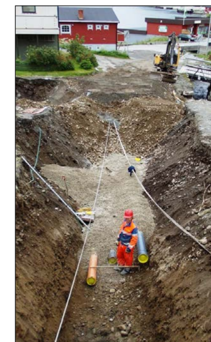
I sommer og høst er det utført et omfattende arbeid med vann og avløp i Kjøllefjord. (Foto: Tor Bjarne Ødegård)
