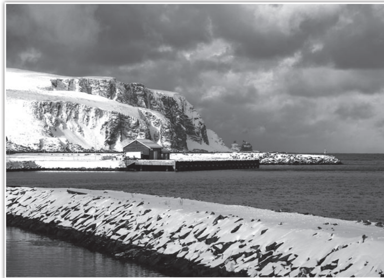
Dampskipskaia i Kjøllefjord er bygd for å klare å imøtekomme framtidens krav for havnetransport. (Foto: Øystein Ingilæ)
